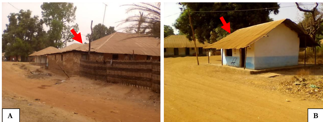
Photo 1/AGEIM-IC: Aperçus de maisons (PK00+600) (A) et du poste de contrôle de la Police (PK00+900) (B) dans l'emprise du projet à Farim/Février 2021
